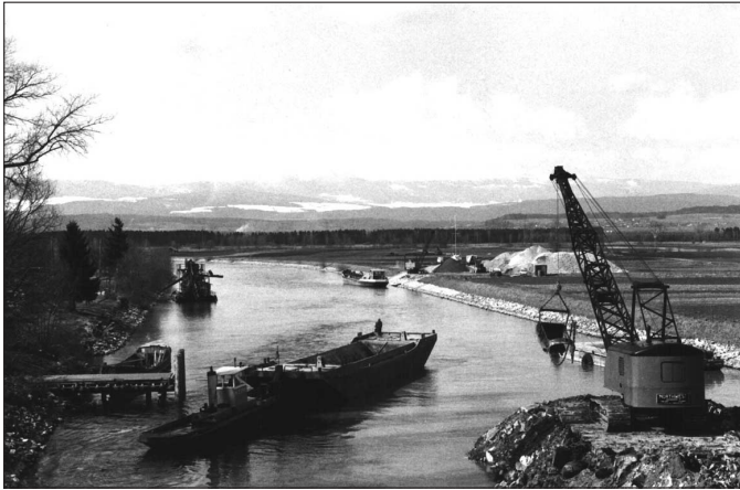
Abb. 7: Arbeiten an der Broye bei Sugiez (FR), letzter Aushub, 1976.
