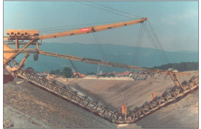
Abb. 8: Aushub des Seebodenkanals, Gampelen, Eimerkettenbagger, 1976.
