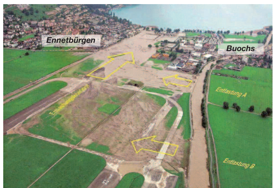
Abb. 4: Die Engelberger Aa beim Abklingen des Hochwassers 2005. Das «Zuviel» an Wasser verlässt das Flussbett an den vorgesehenen Stellen und strömt durch den Entlastungskorridor zwischen Ennetbürgen und Buochs dem Vierwaldstättersee zu. Im Flussbett verbleiben maximal 150 m³/s (Luftbild: Luftwaffe).
