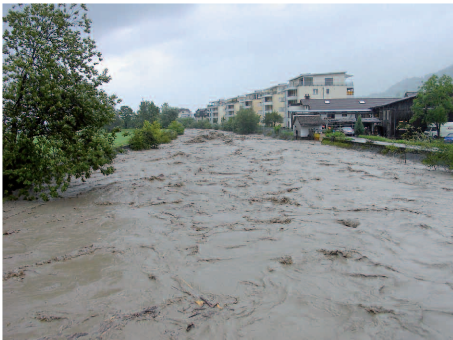
Abb. 5: Die Abflussmenge von 230 \text{ m}^3/\text{s} wurde selbsttätig auf die vorhandene Abflusskapazität von 150 \text{ m}^3/\text{s} in Buochs entlastet. Ohne Entlastungen wäre ein Dambruch in Buochs nicht abzuwenden gewesen.
