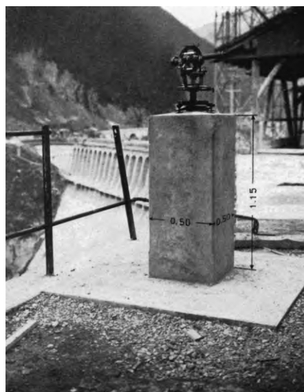
Abb. 2: Beobachtungspfeiler im Netz der Staumauer «Schräh»; Einachsertheodolit von Hildebrand (Lang 1929).
