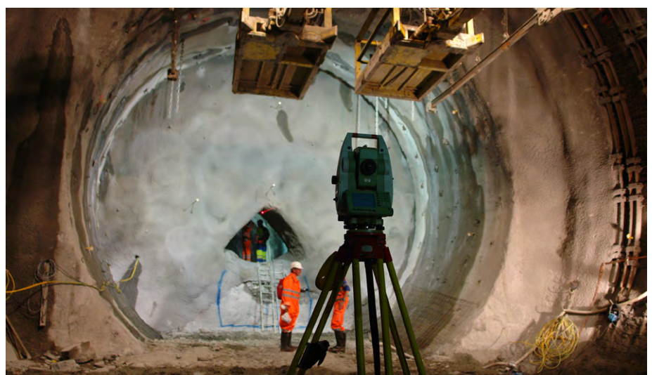
Abb. 6: Bei Bau und Überwachung des Gotthard-Basistunnels der NEAT, mit 57 km längster Eisenbahntunnel der Welt, kommen verschiedene Leica Geosystems-Instrumente zum Einsatz, z.B. Totalstationen, GPS-Systeme und Digitalnivelliere. Die Abweichung auf die gesamte Distanz betrug nur wenige Zentimeter.
