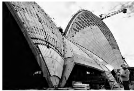
Abb. 4: Wild-Nivelliergerät NA2 im Einsatz beim Bau des Opernhauses Sidney (Eröffnung am 20. Oktober 1973 durch Königin Elisabeth II.).
