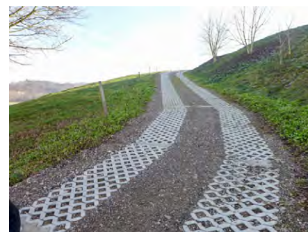
Abb. 10: Ein kurzer steiler Wegabschnitt wurde zur Vermeidung von Erosionsproblemen mit Rasengittersteinen ausgeführt.
