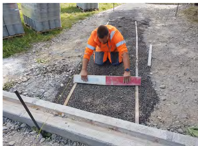
Abb. 9: Vorbereitung der Versetzung der Rasengittersteine (man beachte das negative Dachprofil der Planie der Spur zur Ausbildung einer wasserführenden Rinne mittig der Steine).
