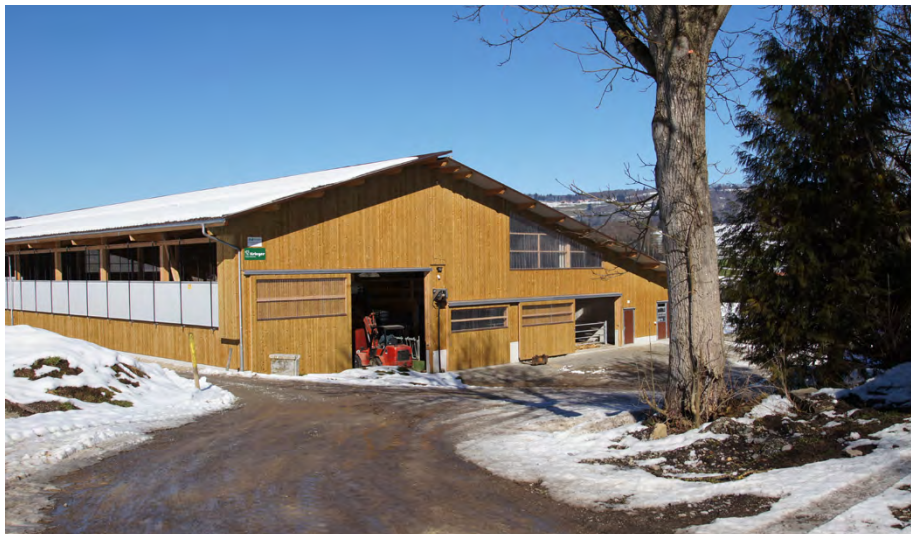
Abb. 1: Auch grossvolumige Ökonomiegebäude lassen sich gut ins Gelände einbetten. Grosse Öffnungen bringen Licht und Luft in die Gebäude (Krieger AG).
