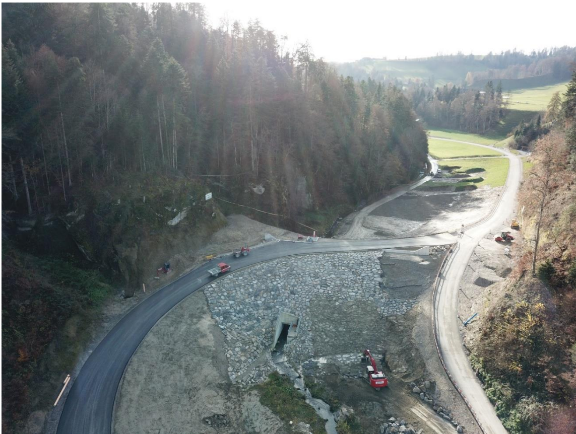
Abb. 2: Sicht auf Talseite des Hochwasserschutzdamms und Einstaubereichs im oberen Teil des Fotos.
