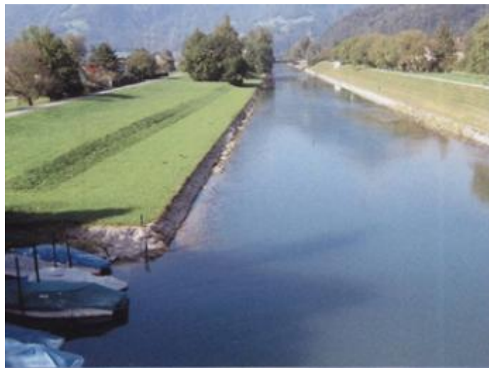
Links der 5 km lange, seit 1811 die Wasser der Linth ab Mollis/Näfels in den Walensee umleitende Escherkanal. Rechts der 17 km lange Linthkanal, der seit 1823 die Wasser von Linth, Maag und Seez sowie weiterer kleinerer Walensee-Bergbäche aus dem als Auffangs- und Ausgleichsbecken genutzten Walensee von Weesen bis Schmerikon bzw. Schloss Grynau in den Oberen Zürichsee leitet. (Fotos aus dem Jahre 2005.) Im rechten Bild ist die Doppel-Trapezform des Kanalprofils gut ersichtlich.
